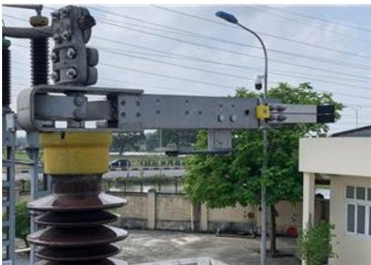
Cảm biến lắp đặt ► Trên đường dây 110kV Hội Hợp, Vĩnh Phúc
