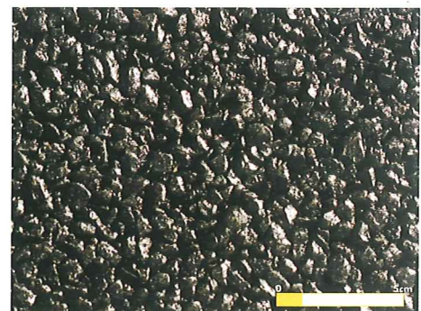
従来ローラ(マカダム+タイヤ)の仕上げ面 (一次転圧湿度：150℃, 二次転圧湿度：80℃, 各5回)
