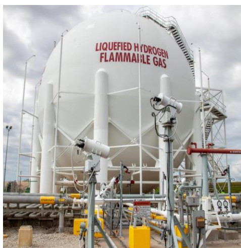
Hình 0.16. Các phương thức lưu trữ trực tiếp hydrogen và hình ảnh thực tế bồn chứa hydrogen công nghiệp tại trạm không gian Kennedy, Florida, Mỹ.
