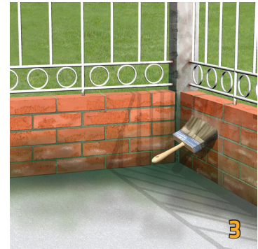
Thi công lớp thứ nhất Sikagard®-905 W bằng cọ hay rulo
