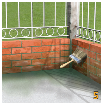
Thi công lớp thứ hai Sikagard®-905 W
