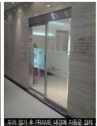
도어 철거 후 FRAME 내경에 자동문 설치
