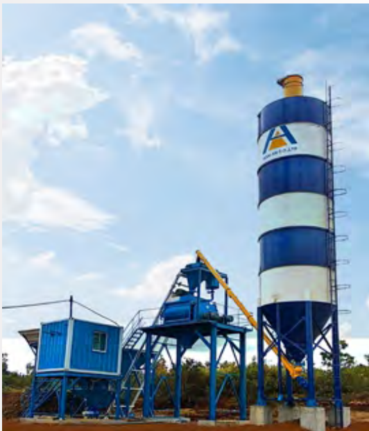
Trạm trộn bê tông tại Đak Lak
