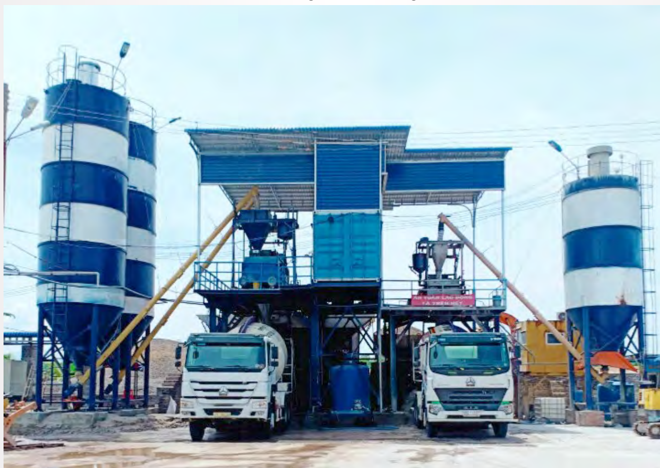
Trạm trộn bê tông đôi Bình Thuận
