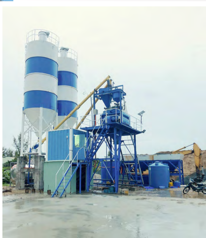
Trạm trộn bê tông An Giang
