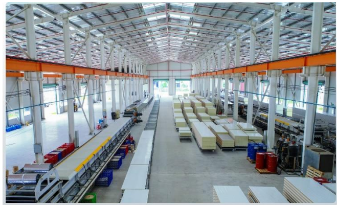
Nhà máy SX Panel chống cháy
