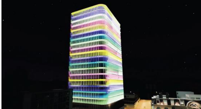
Chiếu sáng mặt ngoài công trình
