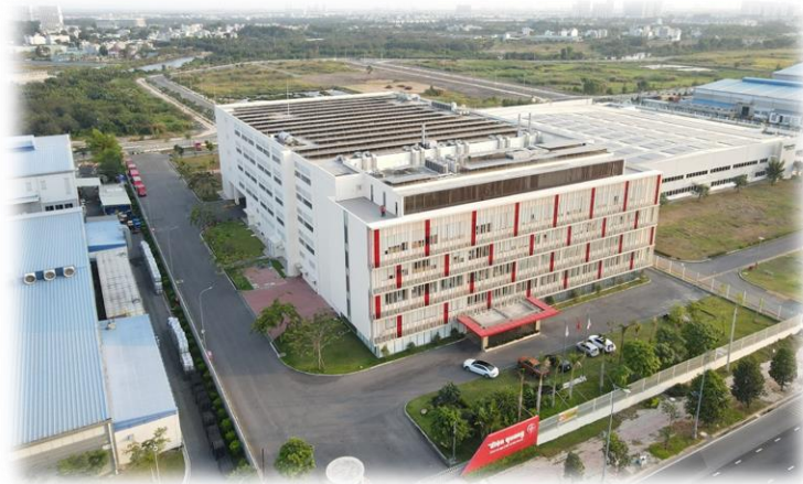
Nhà máy Điện Quang Công Nghệ Cao (Khu CNC HCM-Quận 9)
