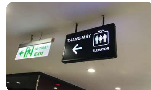
Chiếu sáng khẩn cấp/thoát hiểm
