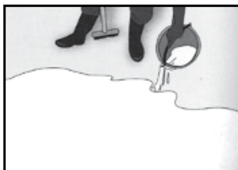
2. Pour the installing area for high level bonding
