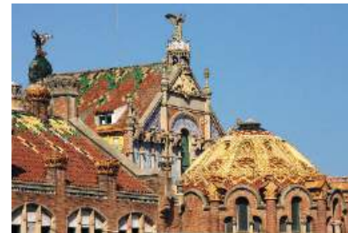
Roof of the Hospital de la Santa Creu i Sant Pau (Barcelona). Picture: Amadalvarez.
