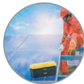
Lắp đặt & vận hành
