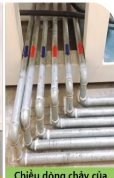
Chiều dòng chảy của đường ống làm mát
