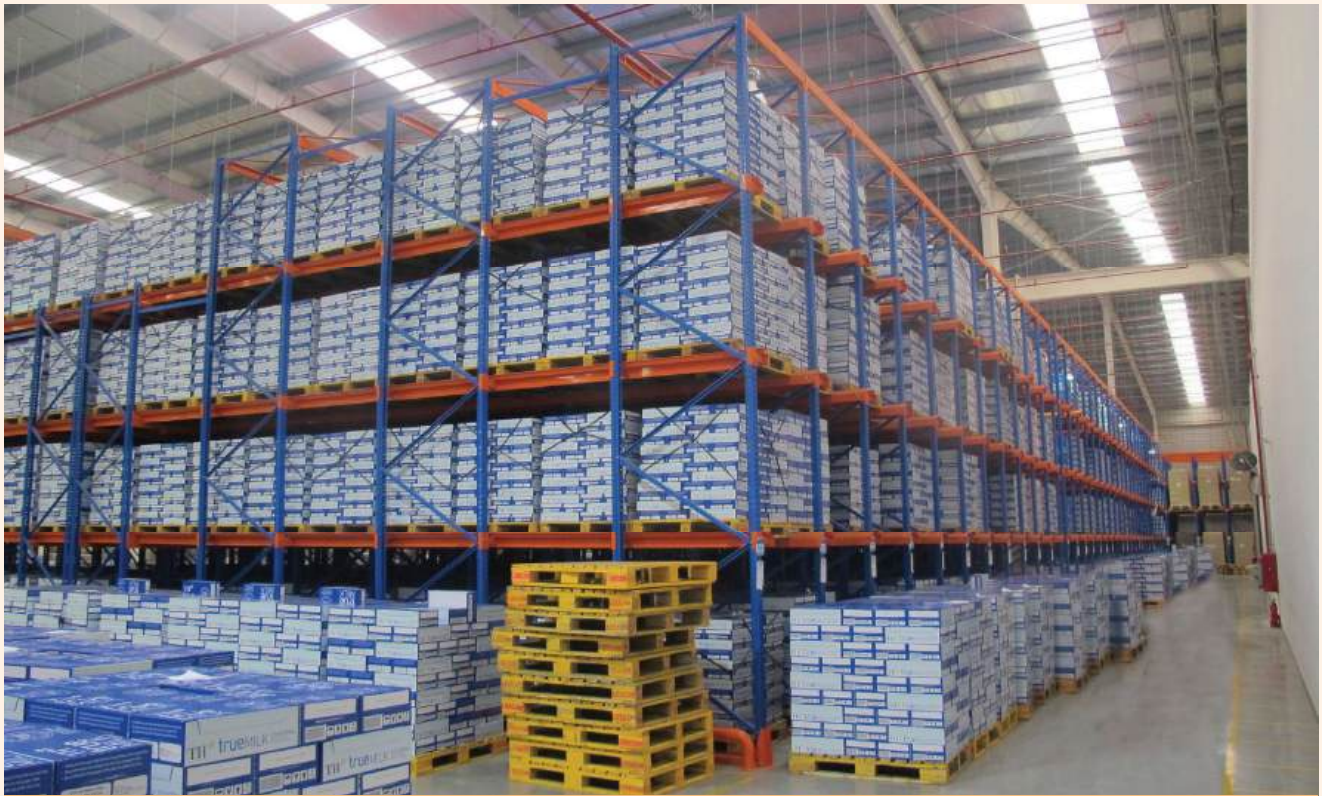
HỆ THỐNG KỆ DRIVE IN - CÔNG TRÌNH TH TRUE MILK
