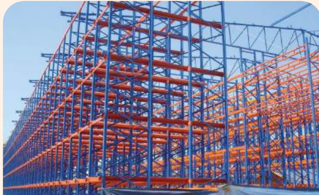
LẮP KHUNG KỆ TRÊN NỀN
