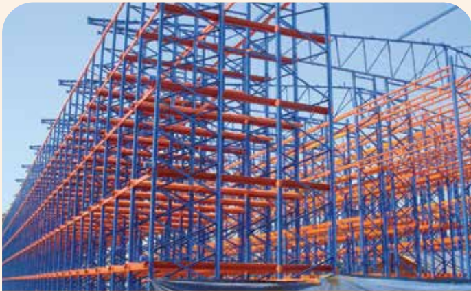
LẮP KHUNG KỆ TRÊN NỀN
