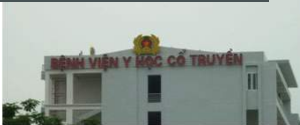
Hệ thống quảng cáo trên cao Tòa nhà Bệnh Viện Y Học Cổ Truyền Bộ Công An : 1,4 tỷ
