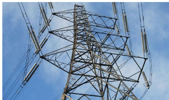
Trụ truyền tải điện Electric power transmission tower
