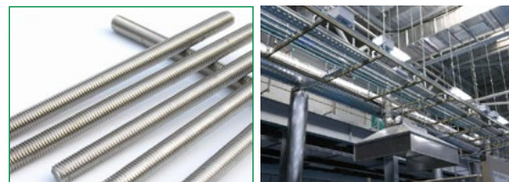
Treo hệ thống cơ điện bằng ty ren xuyên suốt M&E systems are hung by thread rods
