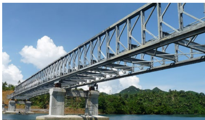
Cầu thép Steel bridge
