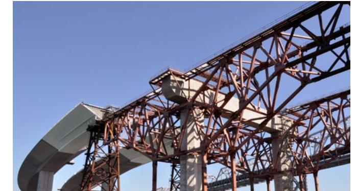
Giàn chống thi công cầu Steel scaffolding to construct bridge
