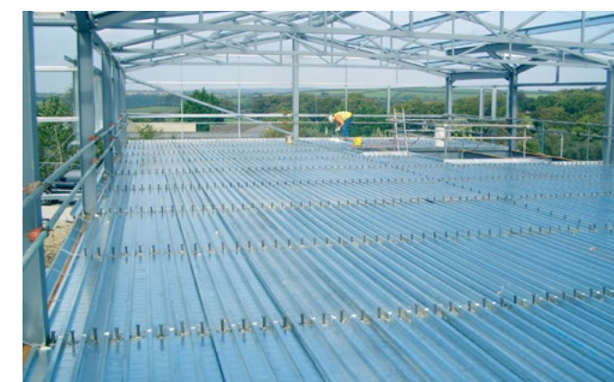
Đinh hàn được ứng dụng trên sàn Decking - nhà xưởng Shear studs are used in Decking floor of factory
