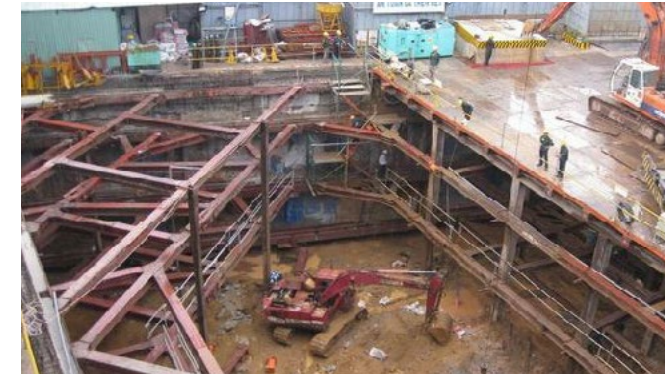
Giàn chống thi công tầng hầm Shoring to construct basement
