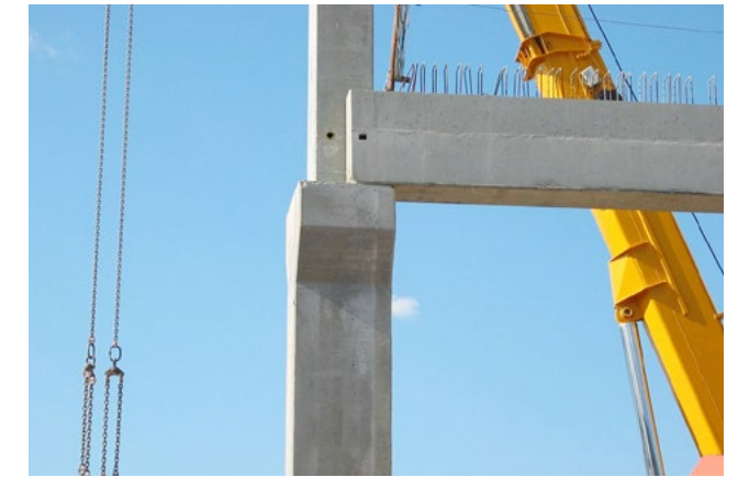
Kết nối dầm và cột bê tông bằng dòng sản phẩm bu lông neo S Connecting beams and pillars by S Insert series
