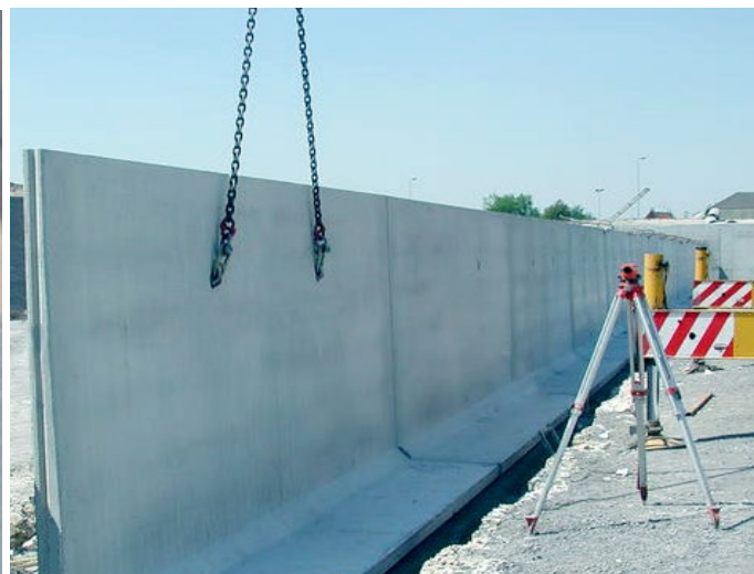
Cấu kiện bê tông đúc sẵn được cầu lắp một cách chuyên nghiệp thông qua thanh cầu DL. Concrete components are erected professionally by DL Anchor
