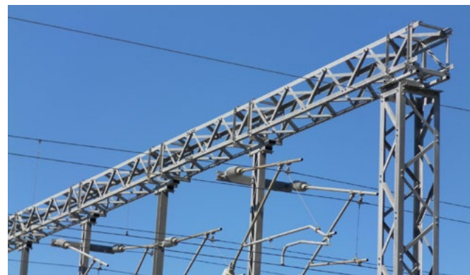
Giàn thép tải điện Gantry tower of electric power transmission
