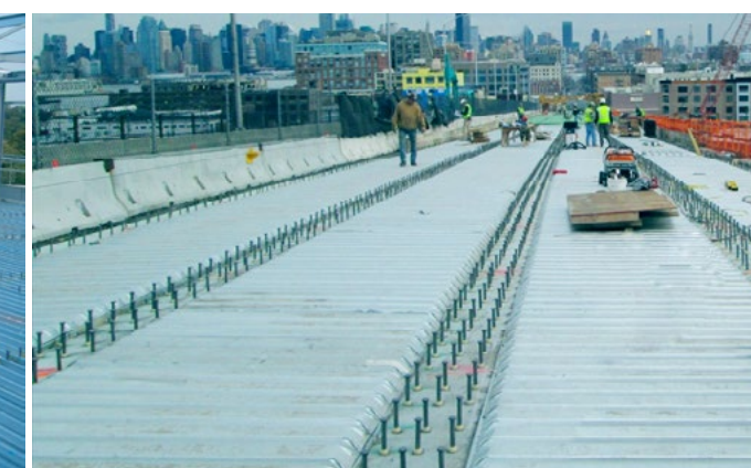
Đinh hàn được ứng dụng trong thi công mặt cầu Shear studs are used in building bridges
