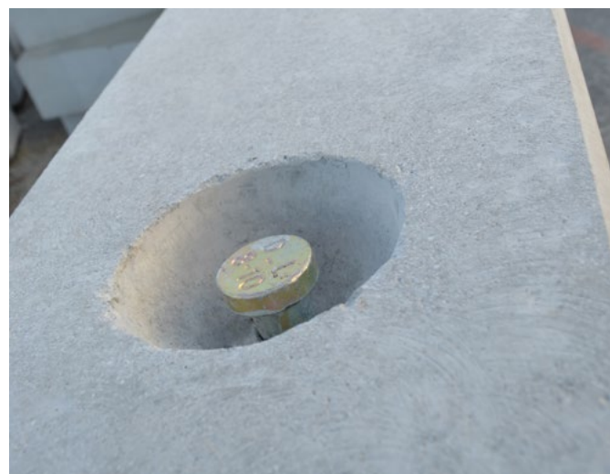
Sau khi tháo Former, một đầu thanh cầu DL lộ ra để liên kết dễ dàng với móc cầu chuyên dụng. After removing the Former, an anchor head exposes to connect with of clutch easily.
